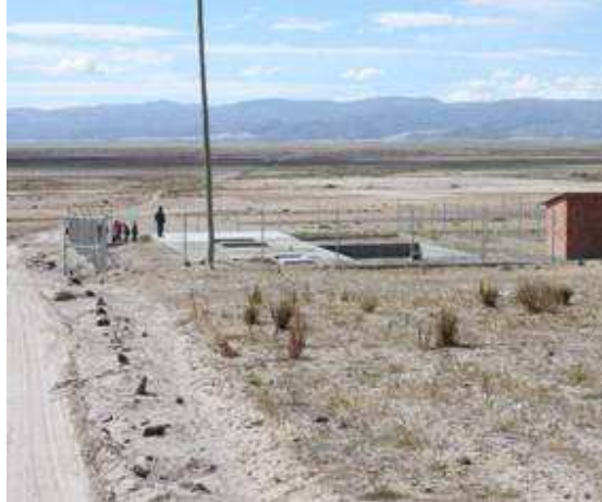
Foto: Planta de Tratamiento de Aguas Residuales del Municipio Santuario de Quillacas
